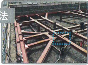
土留壁を抑える油圧ジャッキ
